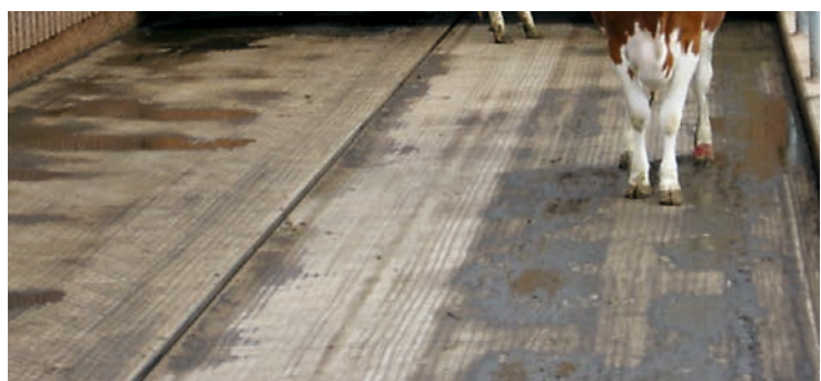
Rysunek 3: Nachylona posadzka o korzystnych właściwościach w zakresie schnięcia
